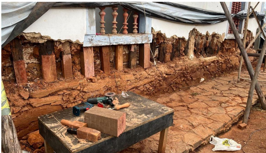
Detalhe da remoção do reboco no embasamento e substituição da madeira do sistema construtivo encontrado em uma das fachadas laterais
