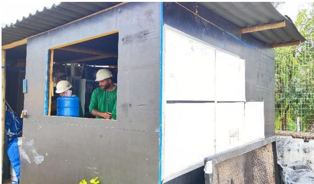
Canteiro de obras implantado Autoria: Francielle Ferreira Data: 23/10/2024
