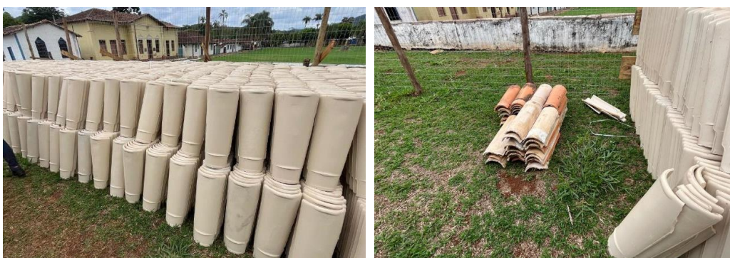
Telhas brancas novas e lavagem das telhas antigas para reaproveitamento Autoria: Natália Morita Data: 23/10/2024
