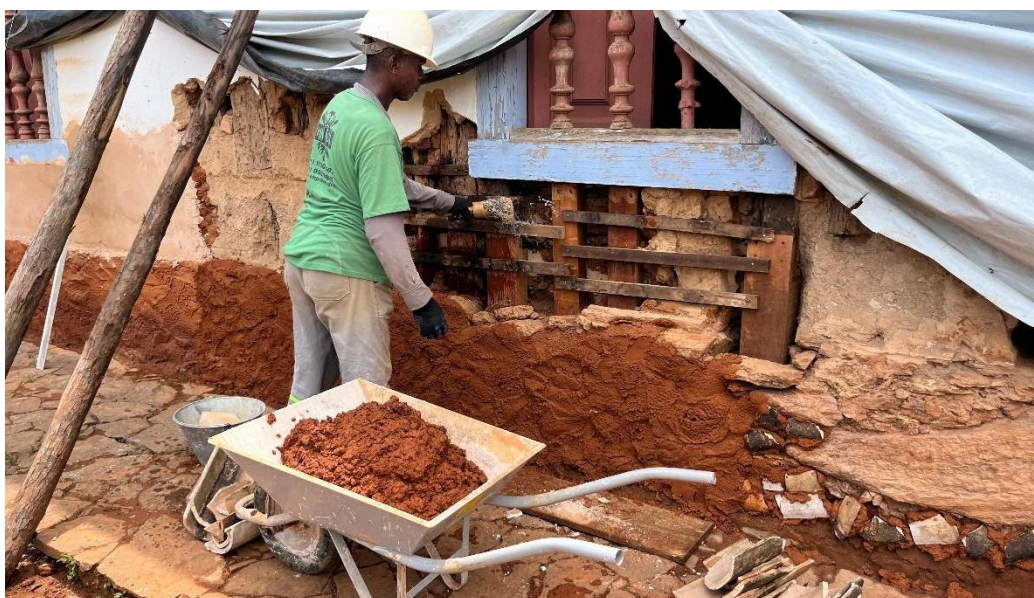
Recomposição do reboco no embasamento em uma das fachadas laterais
